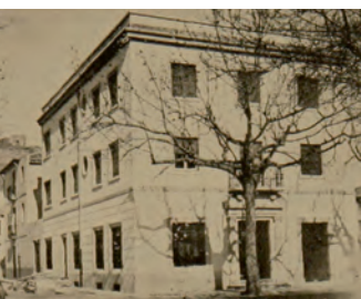
Edificio construido para la Agencia de Denia en 1948
